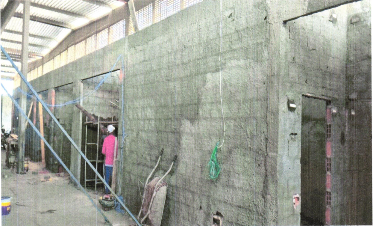
FOTO 30 - (COMPOSIÇÃO REPRESENTATIVA) EXECUÇÃO DE ESTRUTURAS DE CONCRETO ARMADO, PARA EDIFICAÇÃO INSTITUCIONAL TÉRREA, FCK = 25 MPA. AF_01/2017
