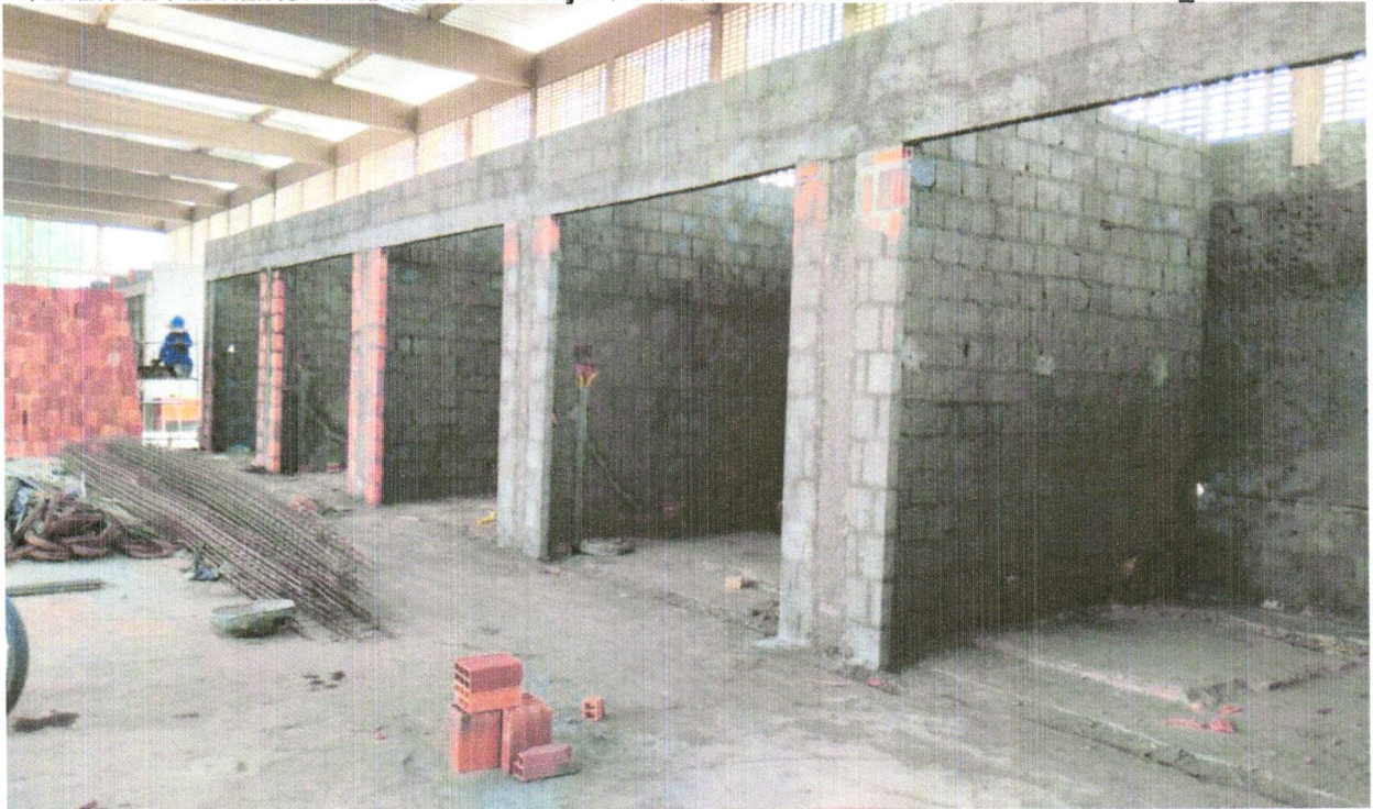
FOTO 34 - CHAPISCO APLICADO EM ALVENARIAS E ESTRUTURAS DE CONCRETO INTERNAS, COM COLHER DE PEDREIRO. ARGAMASSA TRAÇO 1:3 COM PREPARO EM BETONEIRA 400L. AF_10/2022.
