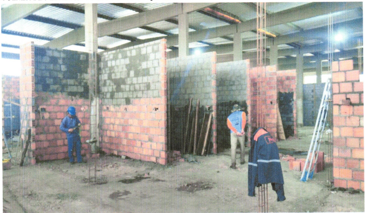
FOTO 34 - CHAPISCO APLICADO EM ALVENARIAS E ESTRUTURAS DE CONCRETO INTERNAS, COM COLHER DE PEDREIRO. ARGAMASSA TRAÇO 1:3 COM PREPARO EM BETONEIRA 400L. AF_10/2022.
