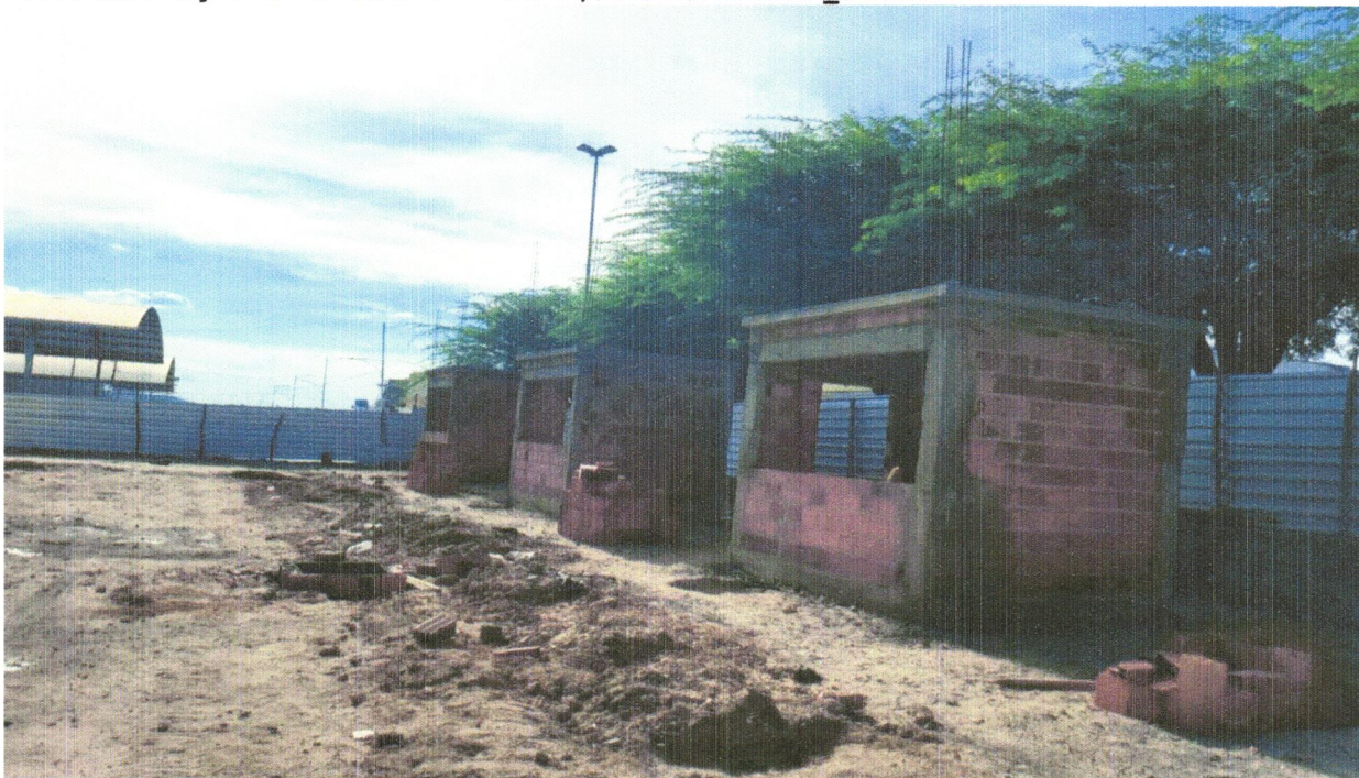
FOTO 58 - (COMPOSIÇÃO REPRESENTATIVA) EXECUÇÃO DE ESTRUTURAS DE CONCRETO ARMADO, PARA EDIFICAÇÃO INSTITUCIONAL TÉRREA, FCK = 25 MPA. AF_01/2017
