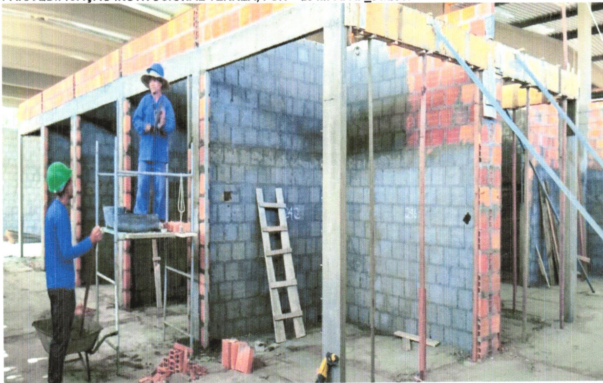
FOTO 28 - (COMPOSIÇÃO REPRESENTATIVA) EXECUÇÃO DE ESTRUTURAS DE CONCRETO ARMADO, PARA EDIFICAÇÃO INSTITUCIONAL TÉRREA, FCK = 25 MPA. AF_01/2017
