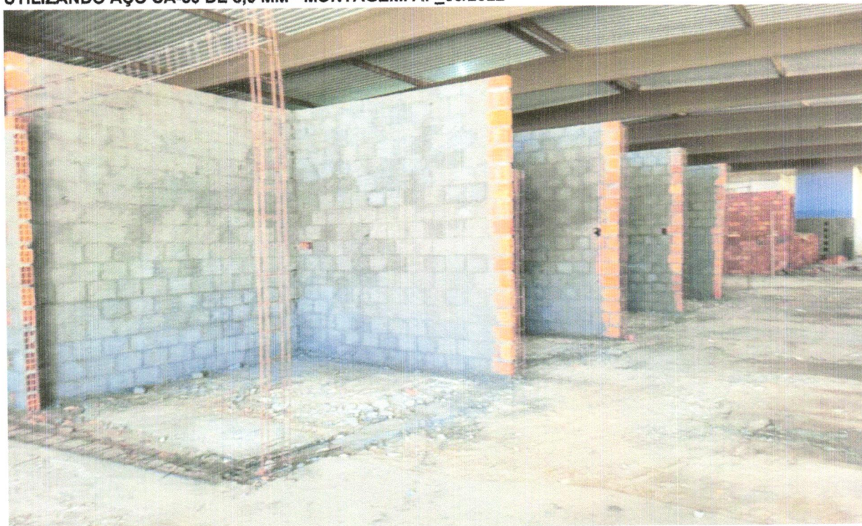
FOTO 24 - ARMAÇÃO DE PILAR OU VIGA DE ESTRUTURA CONVENCIONAL DE CONCRETO ARMADO UTILIZANDO AÇO CA-50 DE 8,0 MM - MONTAGEM. AF_06/2022
