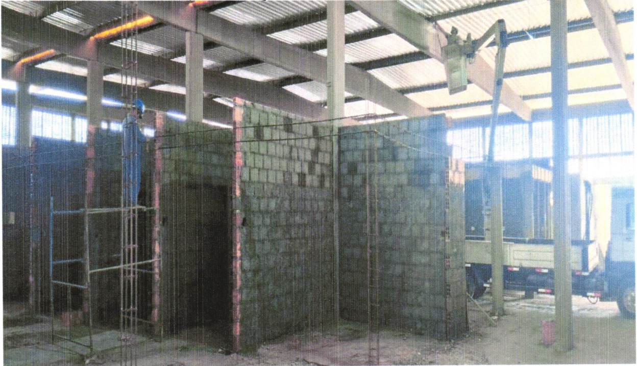
FOTO 32 - CHAPISCO APLICADO EM ALVENARIAS E ESTRUTURAS DE CONCRETO INTERNAS, COM COLHER DE PEDREIRO. ARGAMASSA TRAÇO 1:3 COM PREPARO EM BETONEIRA 400L. AF_10/2022.
