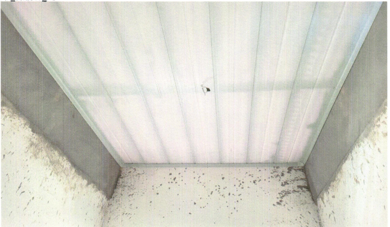
FOTO 54 - FORRO DE PVC, LISO, PARA AMBIENTES COMERCIAIS, INCLUSIVE ESTRUTURA DE FIXAÇÃO. AF_05/2017_PS
