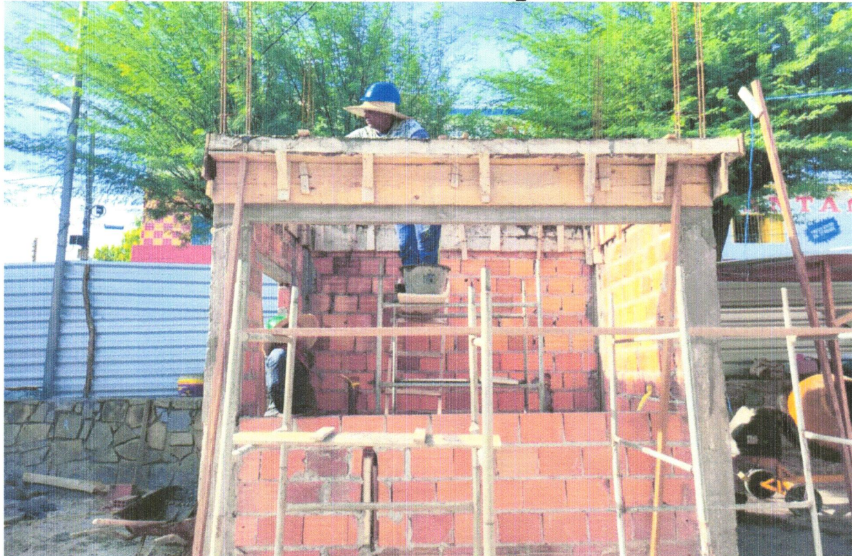
FOTO 58 - (COMPOSIÇÃO REPRESENTATIVA) EXECUÇÃO DE ESTRUTURAS DE CONCRETO ARMADO, PARA EDIFICAÇÃO INSTITUCIONAL TÉRREA, FCK = 25 MPA. AF_01/2017
