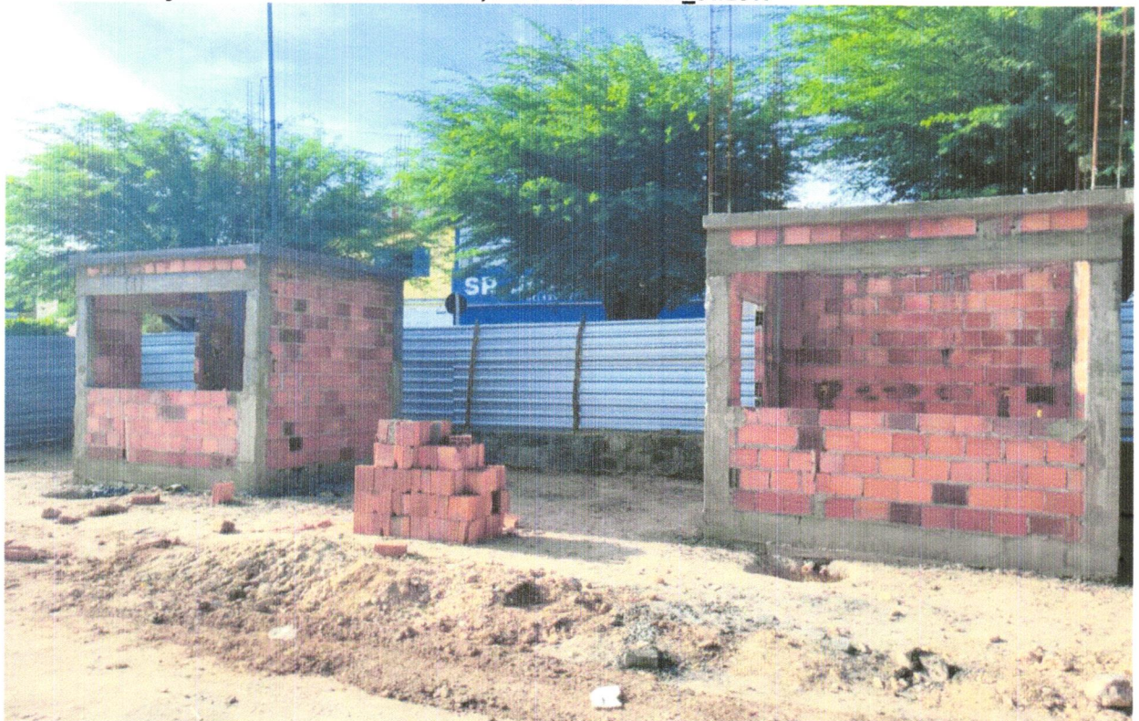
FOTO 56 - (COMPOSIÇÃO REPRESENTATIVA) EXECUÇÃO DE ESTRUTURAS DE CONCRETO ARMADO, PARA EDIFICAÇÃO INSTITUCIONAL TÉRREA, FCK = 25 MPA. AF_01/2017
