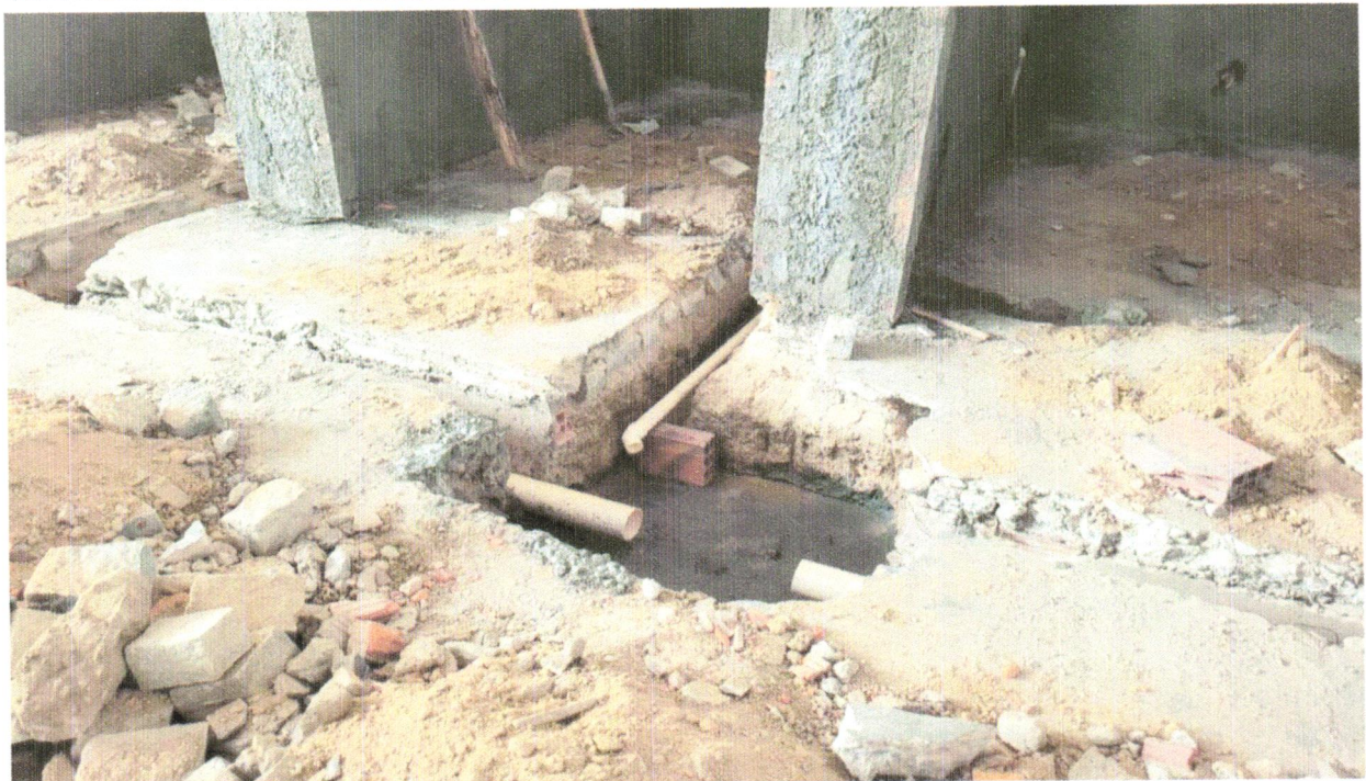
FOTO 14 - TE, PVC, SÉRIE NORMAL, ESGOTO PREDIAL, DN 100 X 50 MM, JUNTA ELÁSTICA, FORNECIDO E INSTALADO EM RAMAL DE DESCARGA OU RAMAL DE ESGOTO SANITÁRIO. AF_08/2022.
