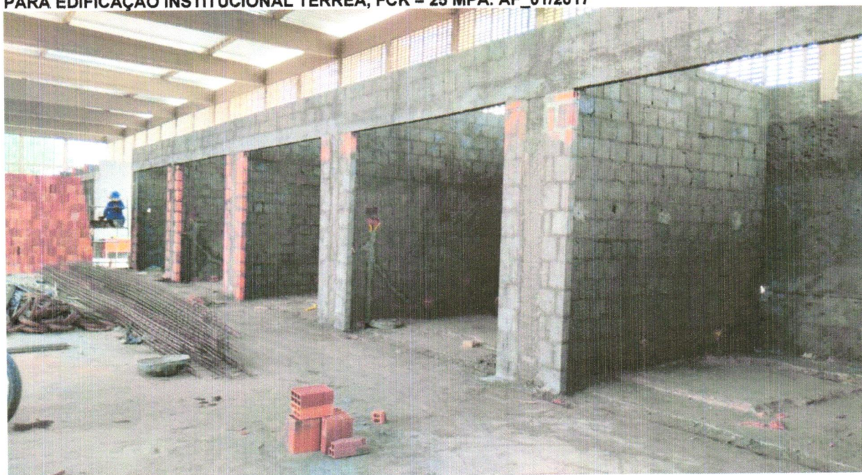
FOTO 28 - (COMPOSIÇÃO REPRESENTATIVA) EXECUÇÃO DE ESTRUTURAS DE CONCRETO ARMADO, PARA EDIFICAÇÃO INSTITUCIONAL TÉRREA, FCK = 25 MPA. AF_01/2017
