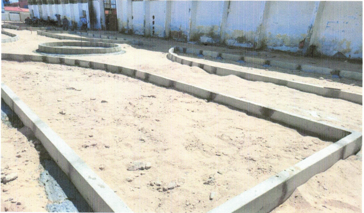
FOTO 64 - GUIA (MEIO-FIO) CONCRETO, MOLDADA IN LOCO EM TRECHO RETO COM
